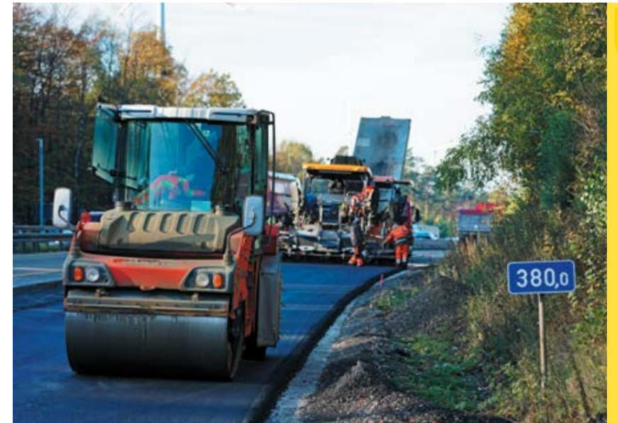
Einbau der Tragschicht: Mit einem Fertiger und einem vorgeschalteten Beschicker-Modul wird der Walzasphalt eingebaut. Die Fahrbahnoberfläche wird in Gussasphalt hergestellt.
