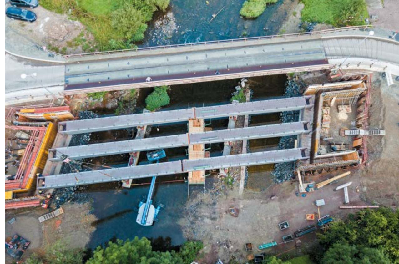
Behelfsbrücke und Fertigteilverlegung aus der Vogelperspektive: Der letzte der sechs Stahlträger (links unten) hängt noch an den Stahlseilen. Die Hohlkästen aus Stahl werden in der Mitte vor Ort verschweißt. Während der Bauphase wurde der Verkehr über die Behelfsbrücke geleitet. Gut zu erkennen ist zudem, dass die Brücke nicht im rechten Winkel zur Ulster ausgerichtet ist.
