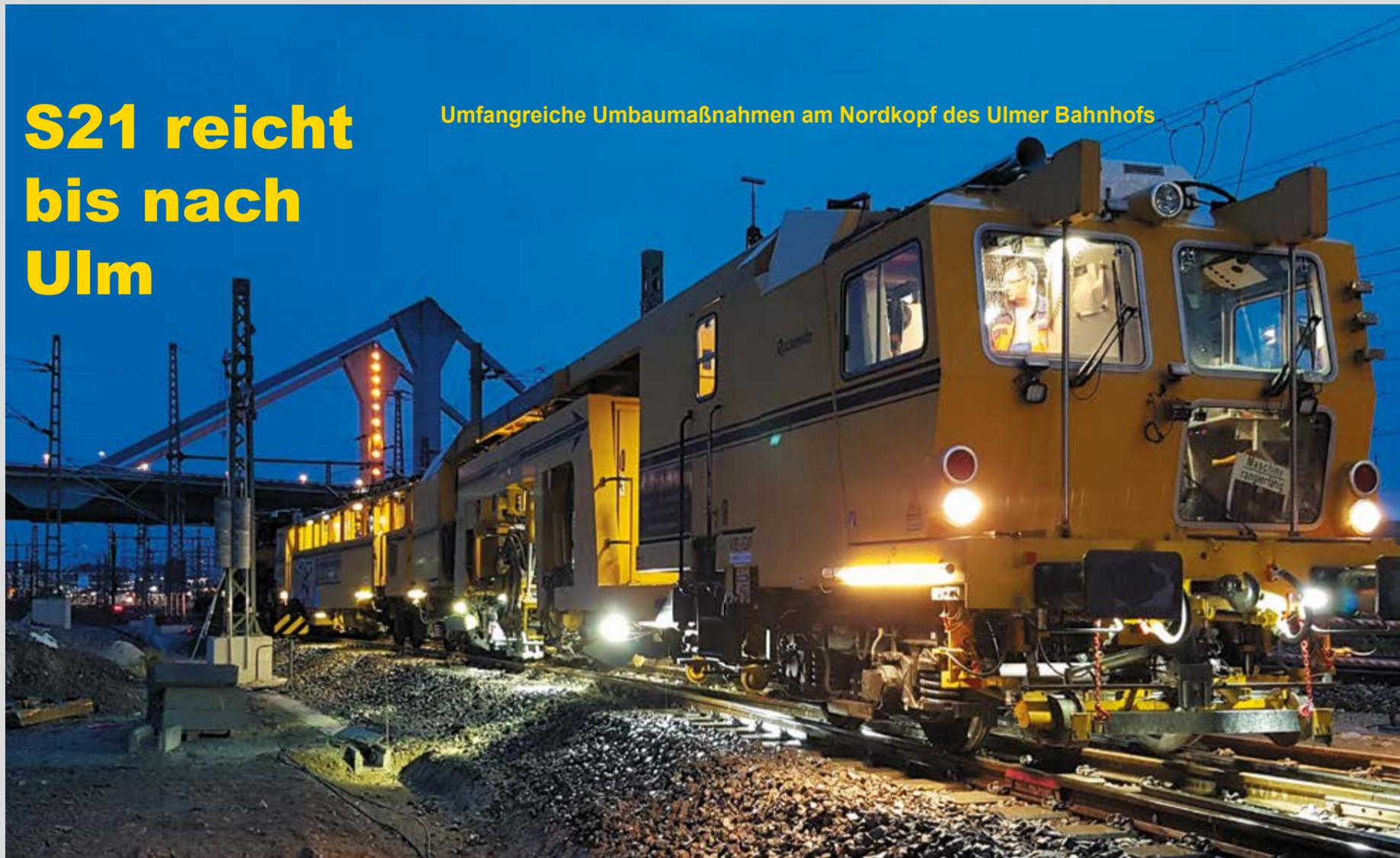
Das neue Gesicht des Ulmer Bahnhofes wird am Nordkopf sichtbar: Die Mitarbeiter der ARGE Bickhardt Bau / Hartung Bau bringen die Gleise und Weichen in ihre endgültigen Positionen. In einer dreiwöchigen Sperrpause, in der der überregionale Zugverkehr in Richtung Stuttgart an dieser Stelle ruhte, wurde Anfang Dezember die Anbindung für die so genannte Filstalbahn hergestellt.
