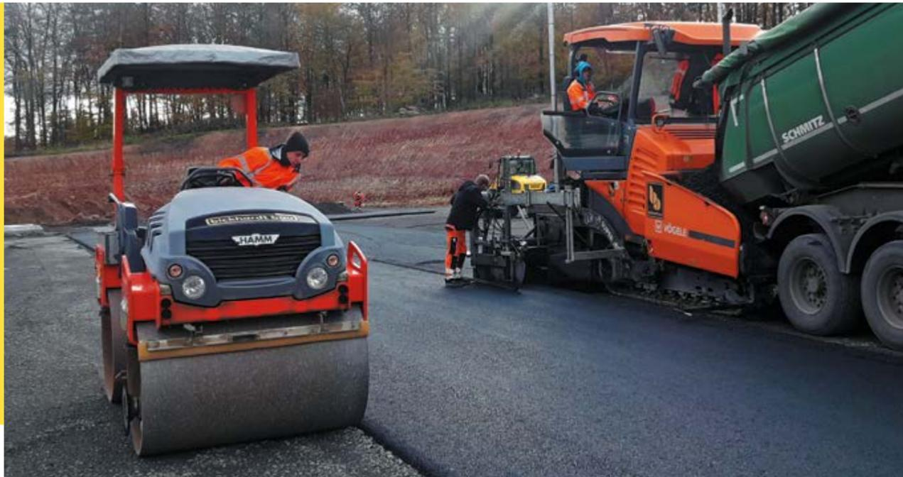
Jonas Friesen, auszubildender Baugeräteführer, muss in der Praxisphase auf der Baustelle tatkräftig mit anpacken. Für das Einbauteam von der Asphalttechnik glättet er mit dem Kantenrad der Asphaltwalze die Flanke der frisch asphaltierten Tragschicht. Da ist viel Finger-spitzengefühl erforderlich.
