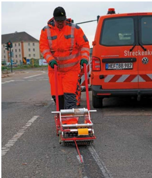
In den weiteren Schritten wird das Markierungsband auf dem mit dem so genannten Primer angesprühten Bereich ausgerollt (Foto links) und anschließend in mehreren Durchgängen angewalzt. Zuvor war der gesamte Arbeitsbereich mit Warnbaken abgesperrt worden.
