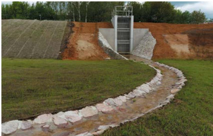
Ausgangspunkt der regen Bautätigkeiten im Metawerk Meerane: Das Regenrückhaltebecken IV an der Gablenzer Straße wurde als erste Baumaßnahme realisiert. Es muss nun allerdings aufgrund der Vollausslastung im Gewerbegebiet vergrößert werden.
