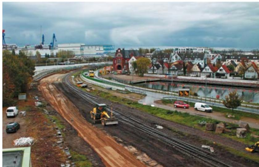
Einbau der Planumschutzschicht mit einem Grader am südlichen Bauende (Foto oben). Der östliche Fernbahnsteig wird mit Fertigteilelementen hergestellt (Foto Mitte). Unsere Aufnahme von Mitte Januar zeigt die Innenseite der späteren Bahnsteigkante. Die Rückwände, die zugleich als Hochwasserschutz dienen, werden später verlegt.
