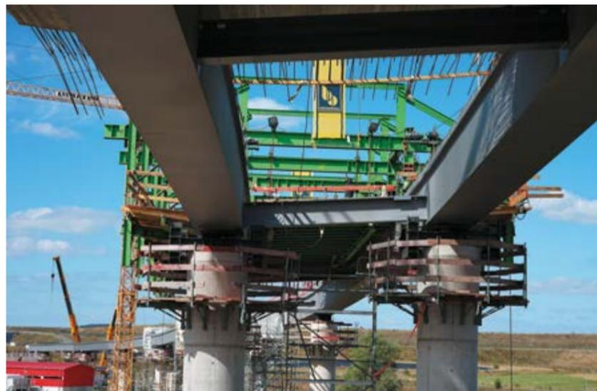
Zwei vor, eins zurück: Beim Einsatz des Schalwagens wird immer ein Betonage-Feld übersprungen und anschließend die Lücke zubetoniert.
