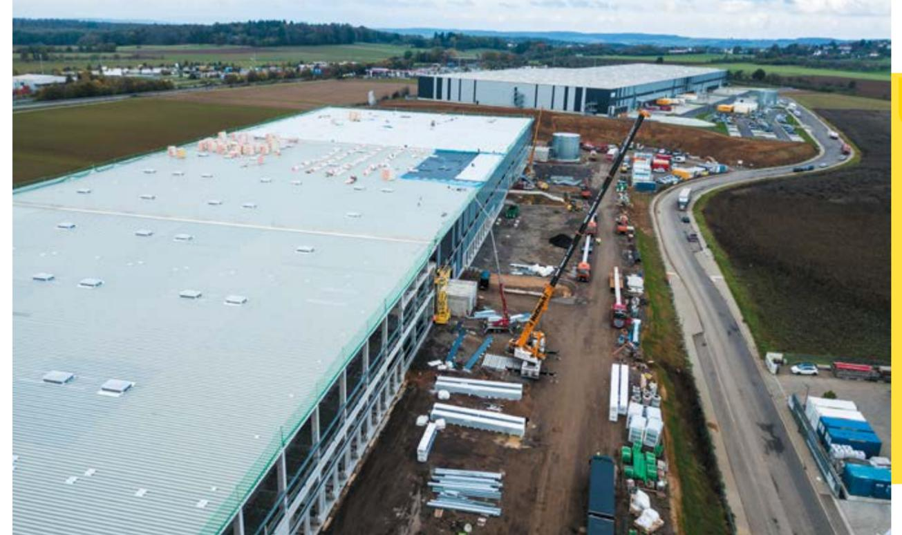
Hammersbach I (oben) und Hammersbach II: Die verschiedenen Bauentwicklungsstufen der Erschließungs- und Tiefbauarbeiten sowie des Hallenbaus sind bei der Realisierung des interkommunalen Gewerbegebietes Hammersbach an der A 45 gut zu erkennen.
