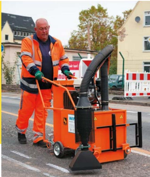
Markierungsarbeiten auf der Aschaffburger Straße vor der ehemaligen Pioneer Park-Kaserne in Hanau: Zunächst wird der Asphalt maschinell angewärmt (Foto links) bevor der Haftvermittler (Primer) aufgesprüht wird (Foto rechts).
