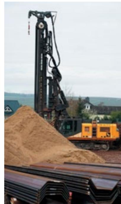
Die Spezialtiefbauer haben mit Spundbohlen eine Vollabdichtung hergestellt. Die Stahlwand reicht bis sechs Meter unter die Geländeoberkante.
