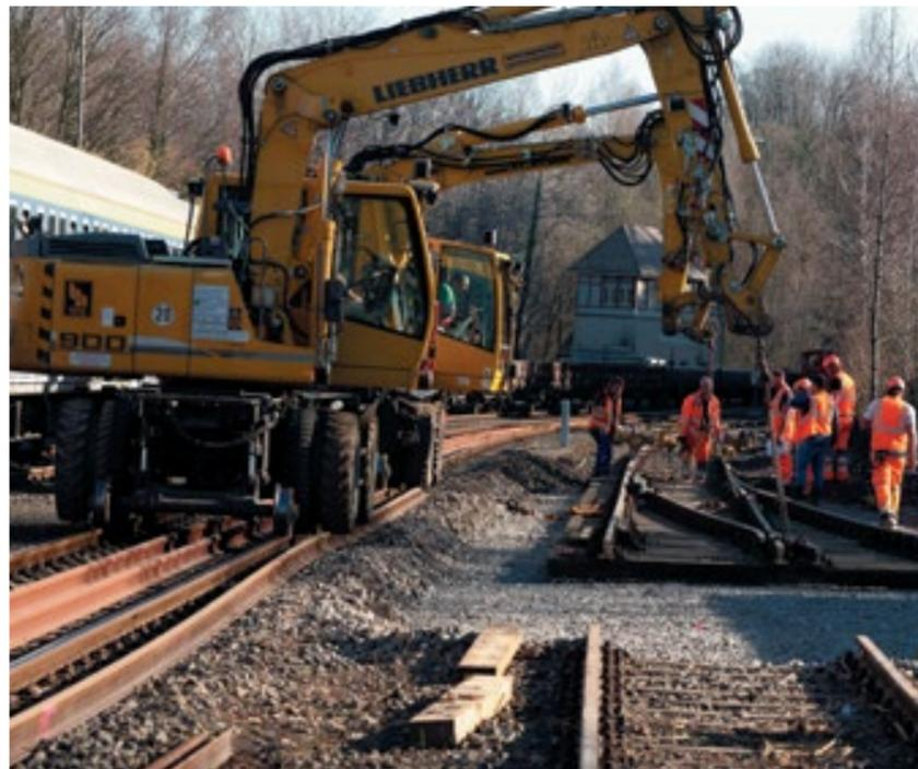
Die Gleisbauer von Hartung Bau verlegen mit Hilfe von Zweibegebaggern eine Weiche (Fotos von oben links nach unten). Die Schienen werden dann vor Ort verschweißt. Die Kuppe der Halde Hahnenfurth wird modelliert. Die neue Querverbindung verläuft in einem Einschnittsbereich. Der Grader ebnet das Frostschutzplanum.
