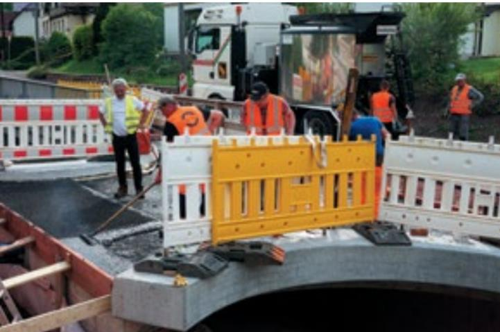
Gussasphalt für eine der kleinsten Brücken in Thüringen. Die lichte Weite beträgt gerade einmal 3,45 Meter.
