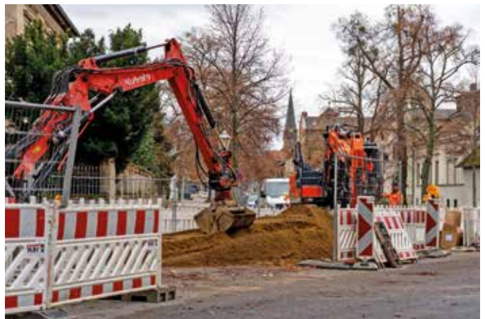
▲ Am nördlichen Ende der Stresemannstraße wird die Dükerung der Bode vorbereitet.
