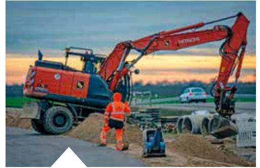
Einbau der Entwässerungsleitungen und Anfüllen der Bankette am Randbereich der K 49.
