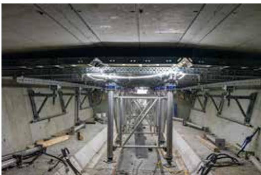
Im Inneren des Hohlkastens: Der Deckenschalwagen kann abgesenkt und über Konsolen verfahren werden.
