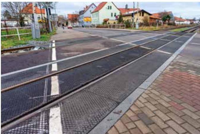
▲ Neuer Bahnübergang am Gernröder Weg in Quedlinburg.
