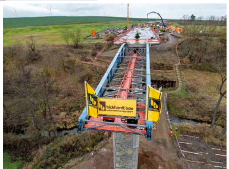
Im Inneren des Hohlkastens: Der Deckenschalwagen kann abgesenkt und über Konsolen verfahren werden.
