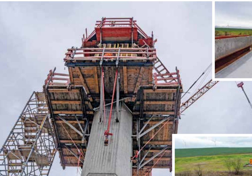
Die Pfeiler wurden abschnittsweise betoniert, die Schalungselemente kletterten entsprechend mit nach oben.
