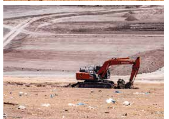
Dauerhaft dicht: Die Deponie am Mittelrücken bei Friedlos wird lagenweise abgedichtet.
