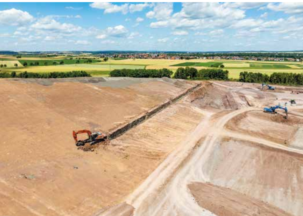
Platz für Neues: Die Deponie Rothmühle bei Schweinfurt wird um neun Hektar erweitert.
