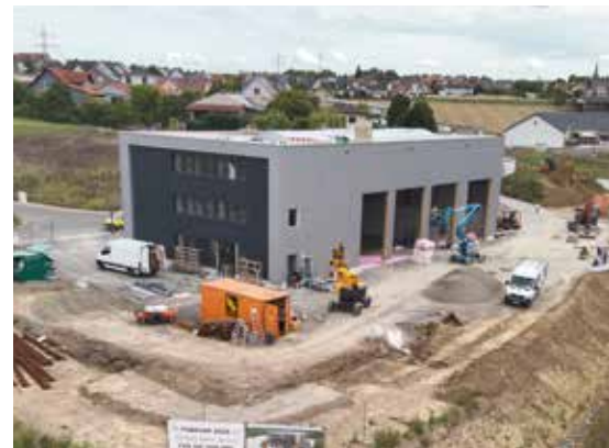
Die Hülle steht, jetzt erfolgt der Innenausbau und die Herstellung der Außenanlagen.
