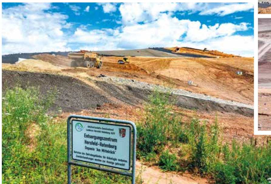
Dauerhaft dicht: Die Deponie am Mittelrücken bei Friedlos wird lagenweise abgedichtet.
