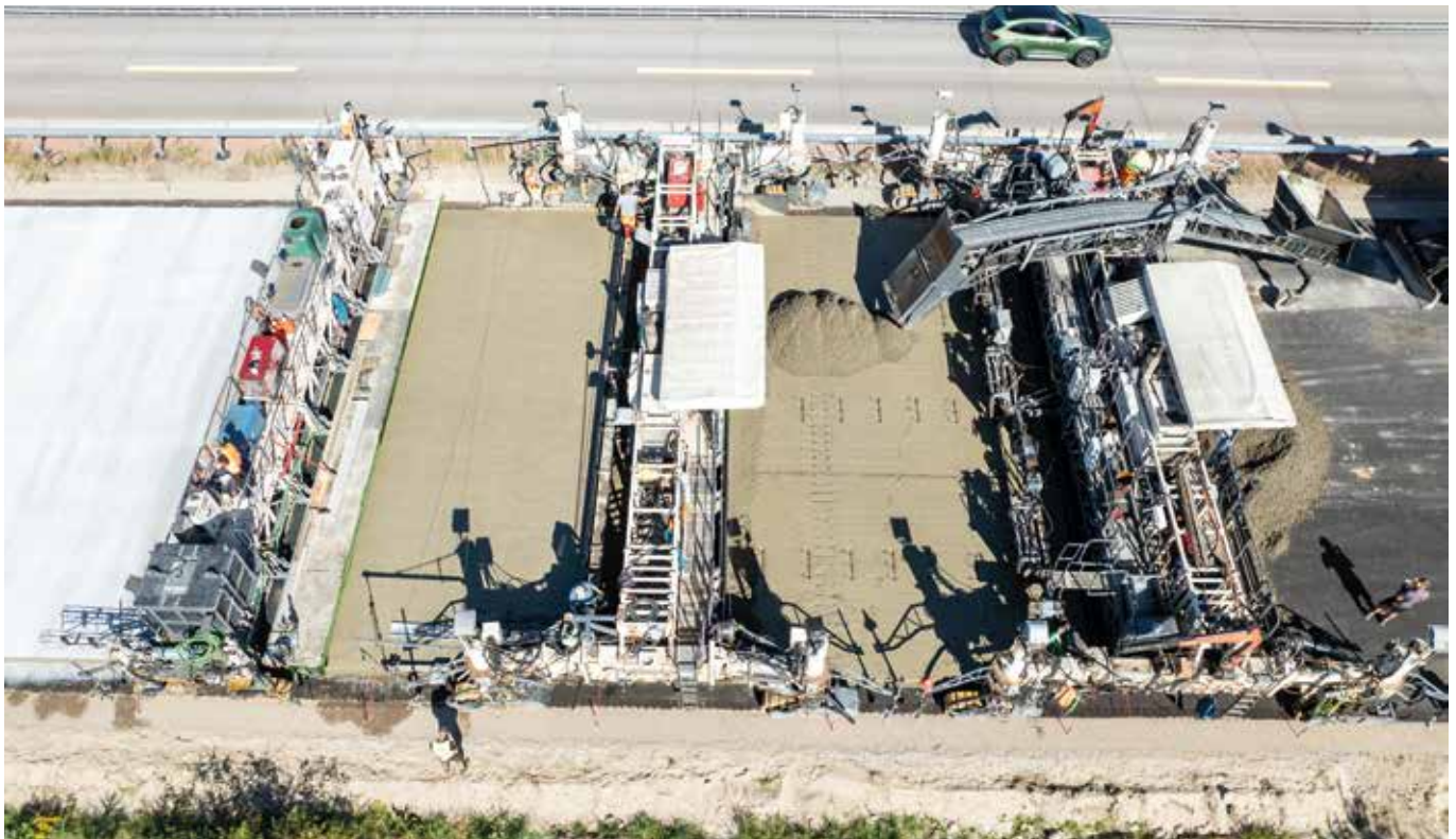
Rollende Straßenbaufabrik: Der Einbauzug im Betonstraßenbau besteht aus zwei hintereinander fahrenden Einbaufertigern und einer Nachlaufbühne.
