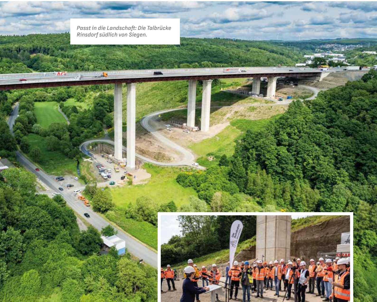
Großes Interesse: Medienvertreter und Bauleute wurden Zeugen, als der nördliche Überbau in seine endgültige Lage gebracht wurde.
