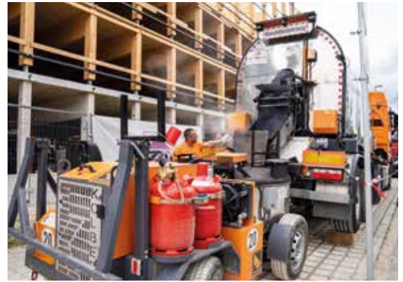
Nachladen am Asphaltkocher vor dem Parkhaus.
