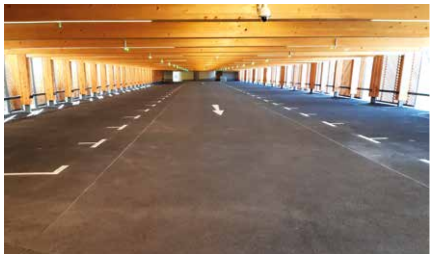
Fertigstelltes Parkdeck mit Markierungen und LED-Parkplatzanzeigen oben zwischen den Holzbindern.
