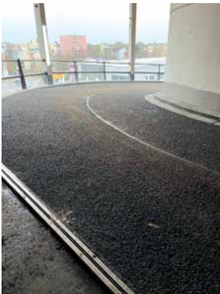
Die Fahrbahnen der Wendelrampen wurden ebenfalls in Gussasphalt hergestellt.
