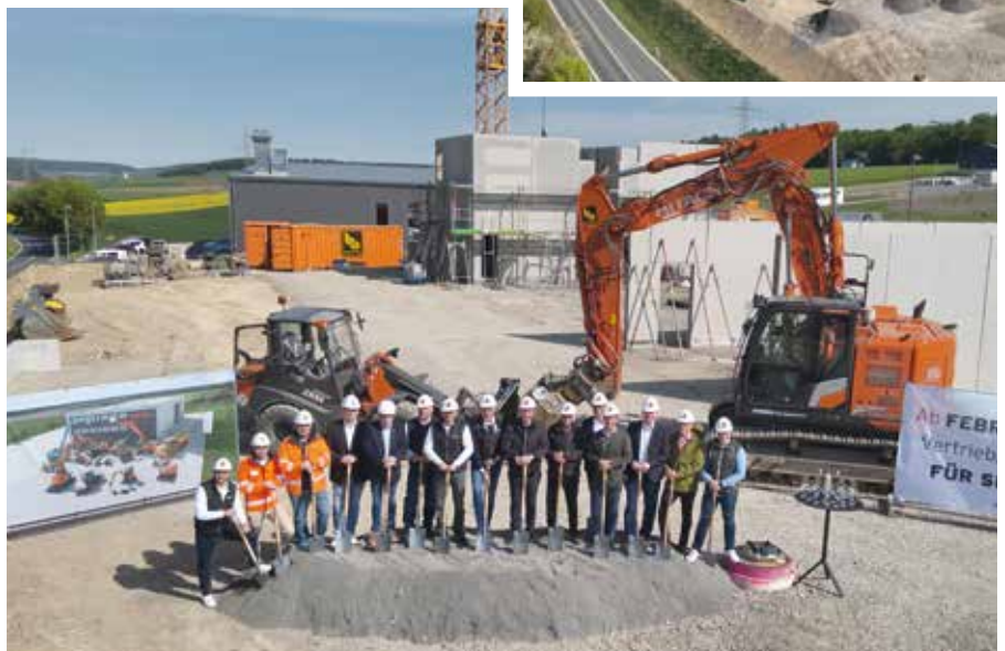
Spatenstich für den Neubau der Kiesel-Niederlassung in Waldbrunn bei Würzburg.
