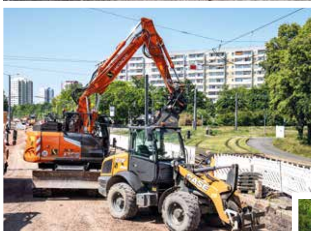
Das ARGE-Team von Bauer und Aust EKS sorgt für die grundhafte Erneuerung des 1.200 Meter langen Streckenabschnitts.
