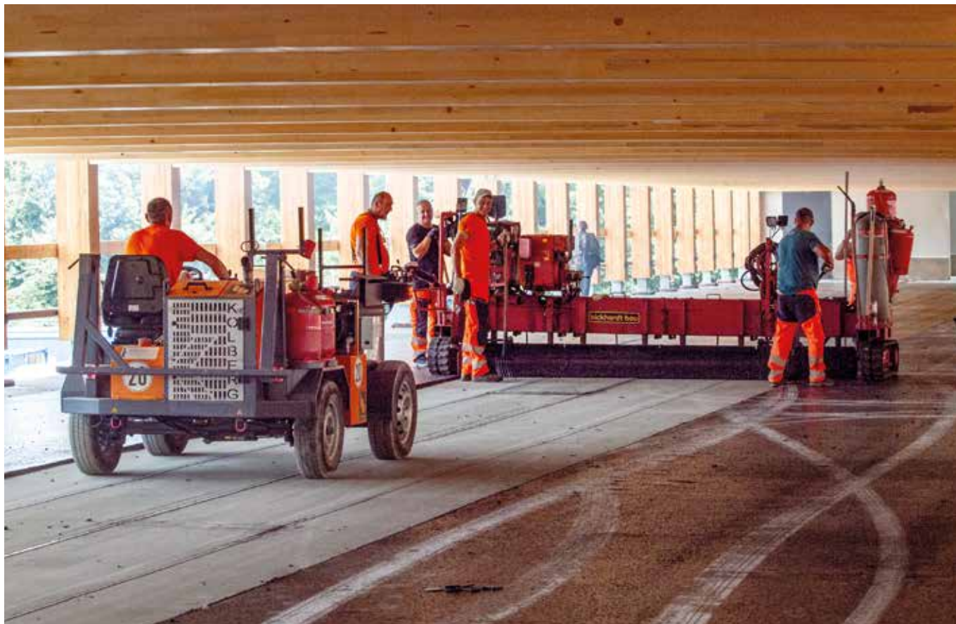
Oben Holz, unten Holz: Mit der Gussasphaltbohle wurde der Gussasphalt auf einer Schweißbahn eingebaut.
