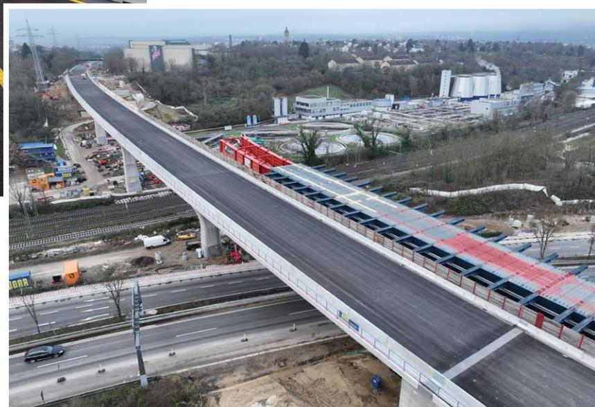
Blick aus der Vogelperspektive: Das südliche Bauwerk der Salzachtalbrücke ist fertiggestellt, der neue Gussasphaltbelag aufgebracht. Zwischen den Pfeilern unter der Brücke befinden sich die Mainzer Straße, die Bahnlinie zum Wiesbadener Hauptbahnhof und die Baustelleneinrichtungsfläche mit den markanten orangefarbenen Bickhardt Bau-Containern. Zum Zeitpunkt der Aufnahme ist auch bereits der erste Taktverschiebung des nördlichen Bauwerks erfolgt. (Luftbild: © Autobahn GmbH / Maurice Kaluscha)
