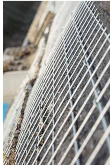
Die Besonderheit steckt im Detail: Um den Flächenverbrauch so gering wie möglich zu halten, wurde der Fahrbahndamm mit bewehrter Erde hergestellt. Amphibienleiteinrichtungen am Böschungsfuß leiten die Kriechtiere direkt zu den entsprechenden Durchlässen.
