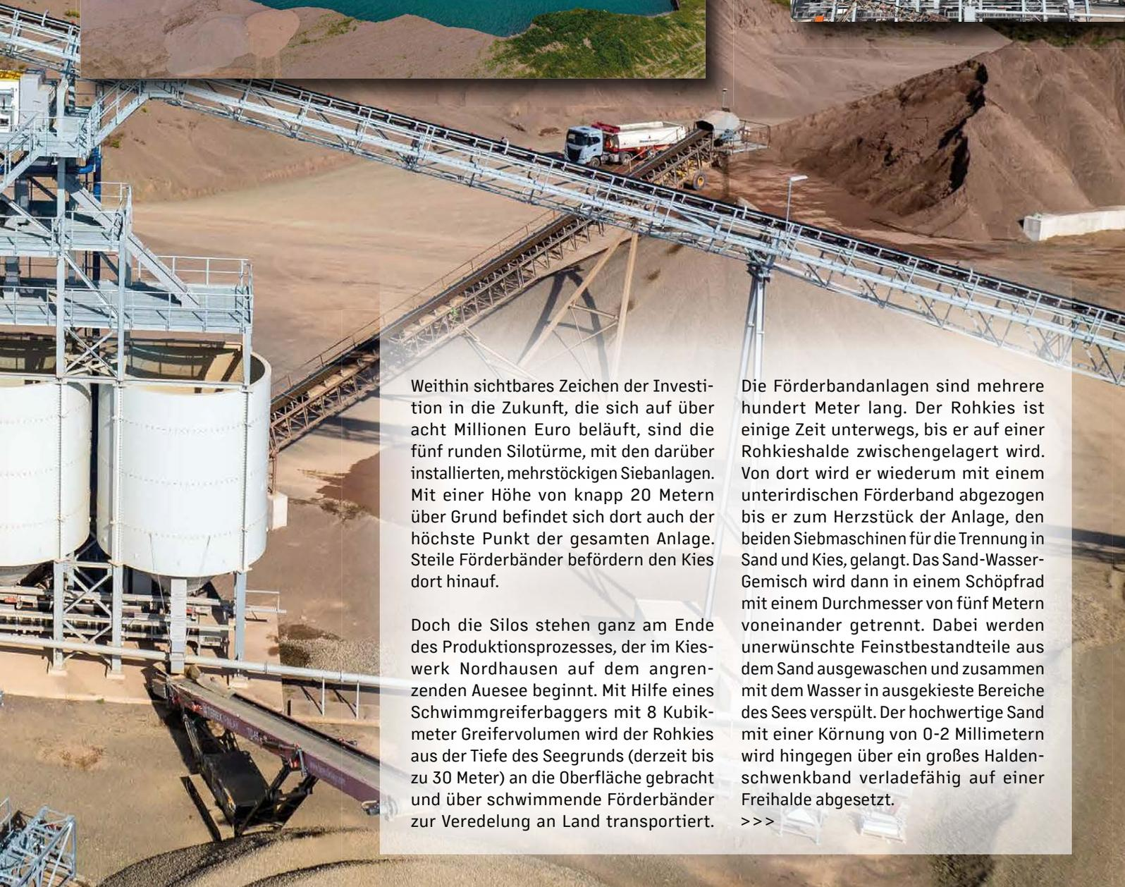
Weithin sichtbares Zeichen der Investition in die Zukunft, die sich auf über acht Millionen Euro beläuft, sind die fünf runden Silotürme, mit den darüber installierten, mehrstöckigen Siebanlagen. Mit einer Höhe von knapp 20 Metern über Grund befindet sich dort auch der höchste Punkt der gesamten Anlage. Steile Förderbänder befördern den Kies dort hinauf.
