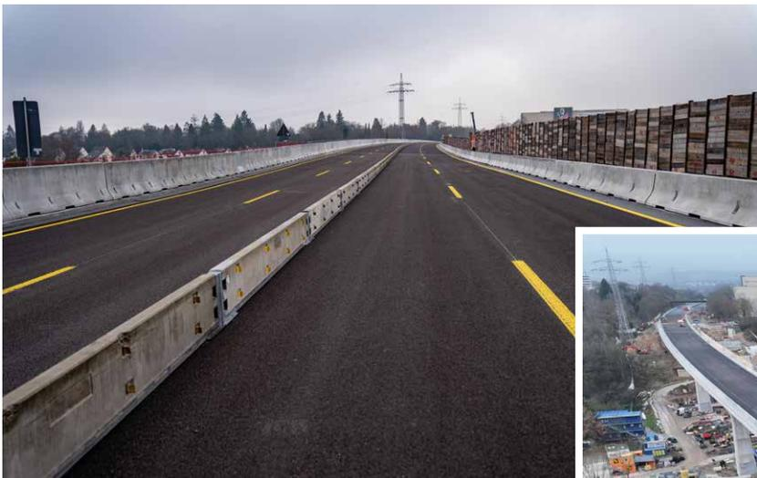
Aus einem Guss: Die frisch asphaltierte Fahrbahnoberfläche der Salzachtalbrücke wurde von unserer Abteilung Gussasphalt hergestellt.
