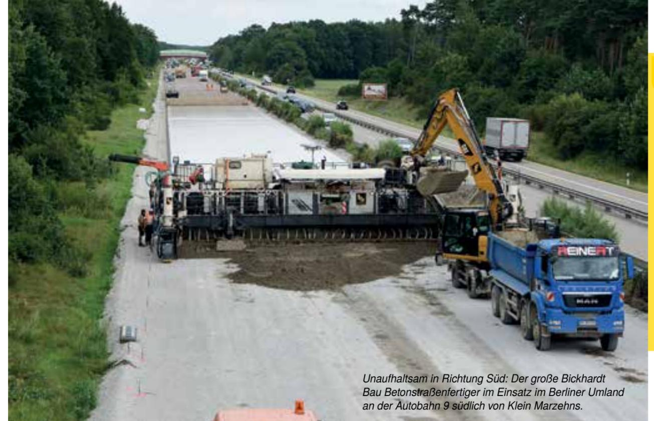
Unaufhaltsam in Richtung Süd: Der große Bickhardt Bau Betonstraßenfertiger im Einsatz im Berliner Umland an der Autobahn 9 südlich von Klein Marzehns.
