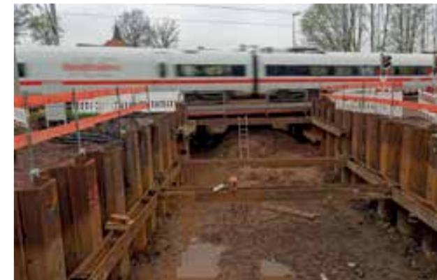
Blick in die gespundete Baugrube: In diesem Bereich wird später der 15 Meter lange Fußgängertunnel eingeschoben.
