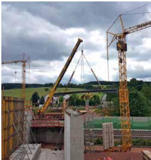
Fertigteil am Haken: Für die neue Straßenbrücke am Ortsrand wurden über 30 Meter lange Stahlträger eingehoben.
