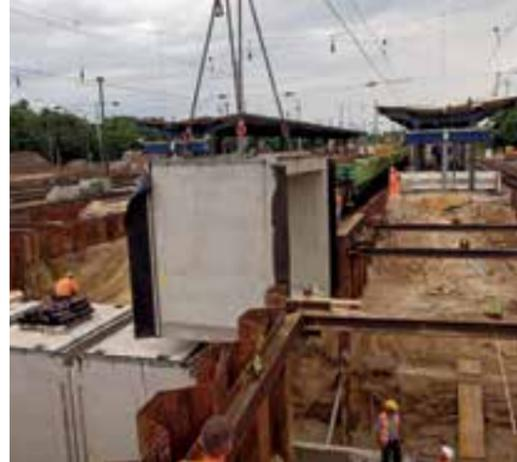
Zum Umbau des Bahnknotenpunktes Ruhland gehörte auch der Bau eines Fußgängertunnels. Zunächst wurden Verbauten hergestellt und das Fundament hergestellt (Foto oben links). Die einzelnen Tunnelsegmente wurden eingehoben und miteinander verschweißt (oben rechts, unten links). Über eine lange Rampe gelangt man nun barrierefrei zu den Gleisen (unten rechts).
