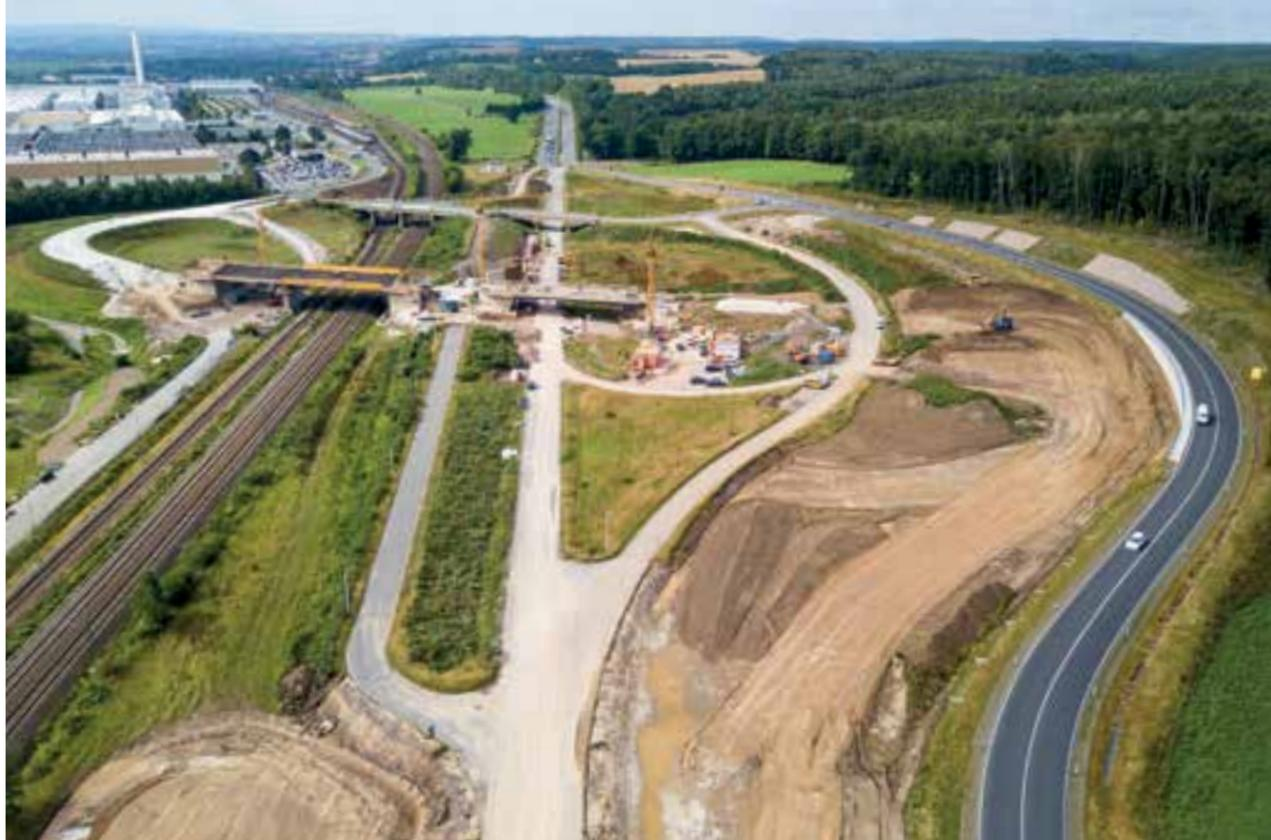
Links das VW-Werk, rechts die Umfahrung, dazwischen der Baustellenbereich für den neuen Verkehrsknoten an der Bundesstraße B 175 bei Mosel. Auch abseits des öffentlichen Straßenverkehrs herrscht jede Menge Betrieb. Drei Kräne markieren den Bereich der Ingenieurbauer, die zwei Brücken herstellen. Eine Raupe schiebt den Oberboden für die Auf- und Abfahrten.
