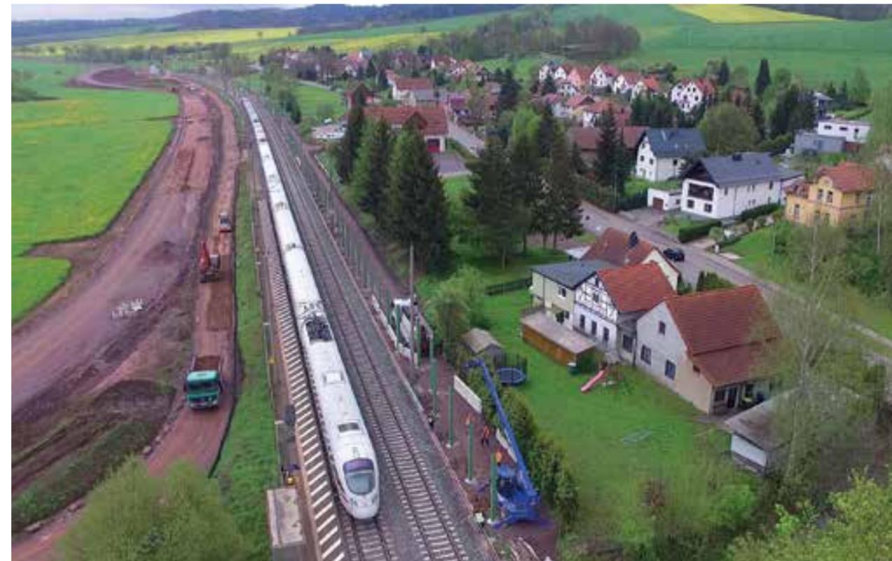
Der Straßenverkehr wird über eine neue Fahrbahn (links) parallel zur Bahnlinie und eine neue Brücke über die Gleise angebunden.
