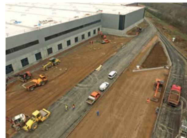
*Die Zufahrten um das Gebäude sind bereits asphaltiert. Zwischen den Umfahrungen wurden die Lamellenklärer mit Bodenmaterial abgedeckt, direkt vor dem Gebäude entstehen die Tiefhöfe mit den Andockstationen.*
