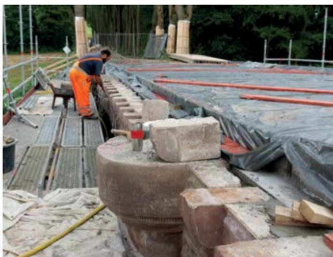
Passgenau: Die einzelnen Mauersteine aus Sandstein werden mit Hand wieder an ihren angestammten Platz eingebaut. Sie waren deshalb zu Baubeginn genau markiert worden.
