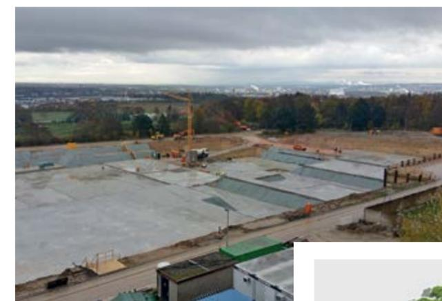
Klinikneubau in Wiesbaden: 150.000 Kubikmeter Boden wurden bewegt (oben). Oben grauer Himmel, unten grauer Beton: Auch die Herstellung einer Sauberkeitsschicht gehörte zum Auftrag (mitte). Die Grafik unten zeigt die Ansicht der Klinik.
