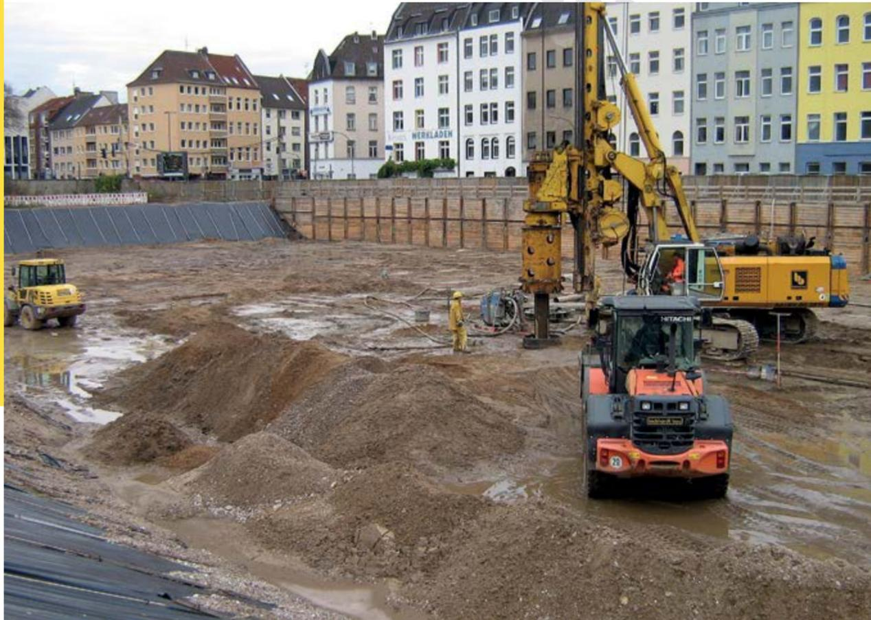
Schweres Baugerät im Einsatz: Die Spezialtiefbauer von Bickhardt Bau haben für den Neubau des Kölner Stadtarchivs die Baugrube hergestellt. Mit einem Drehbohrgerät haben sie 186 Bohrpfähle fast 20 Meter tief in den Baugrund eingebracht, um diesen dauerhaft zu stabilisieren. Ein rückverankerter Berliner Verbau schützt die Straße Eifelwall gegen ein Wegrutschen.
