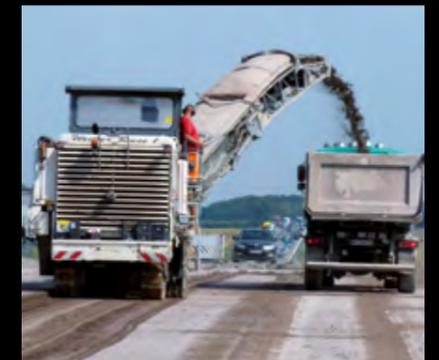
*Er fräst nicht nur sauber, sondern verlädt das Material gleich mit: Der „Weiße Riese“, so steht ‚s auf dem Heck der Großfräse, trägt die Betondecke schichtweise und millimetergenau ab.*
