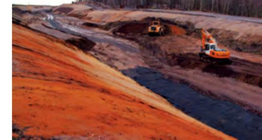
Großflächiger Erdbau und geotechnische Verbesserungen: Die Trasse der A 72 bei Borna führt durch sandiges und zum Teil bergbaulich genutztes Gelände. Durch den Einsatz von Kalkstreuern und Fräsen (Foto links) sowie mit dem Auslegen von Geogittern (oben) werden diese Bereiche stabilisiert und tragfähig gemacht.
